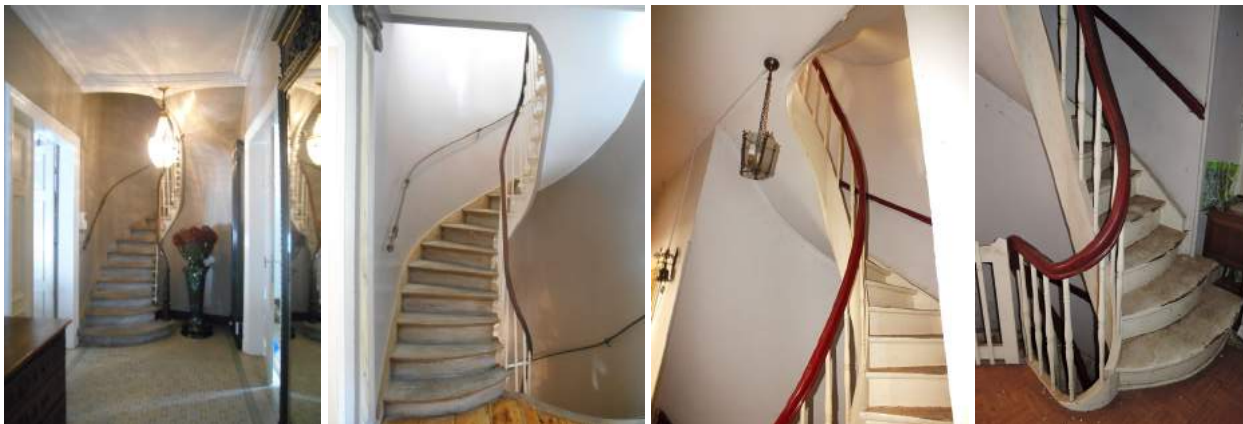
Afb. 49: Referentiefoto's compacte slingertrap uit de negentiende eeuw ©ARAT
