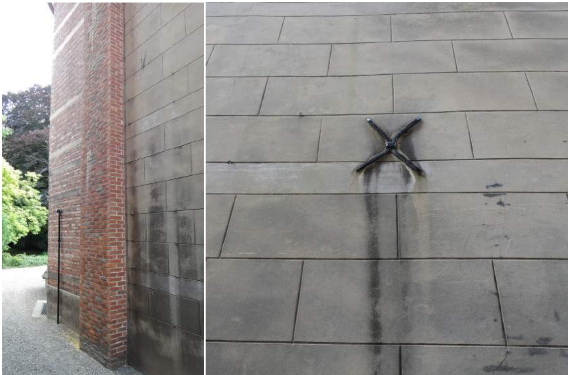
Afb. 18: Typische manieren om bouwsporen te verbergen: cementering van het oudste deel van de gevel, met ingetrokken schijnvoegen om natuursteenparament na te bootsen
