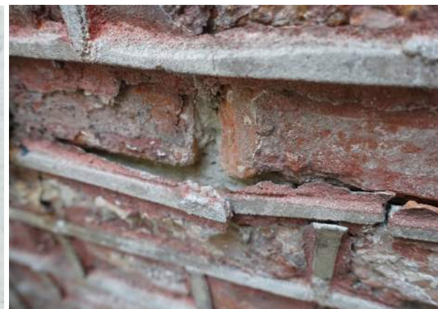
Afb. 41: Knipvoegen en roodschildering
