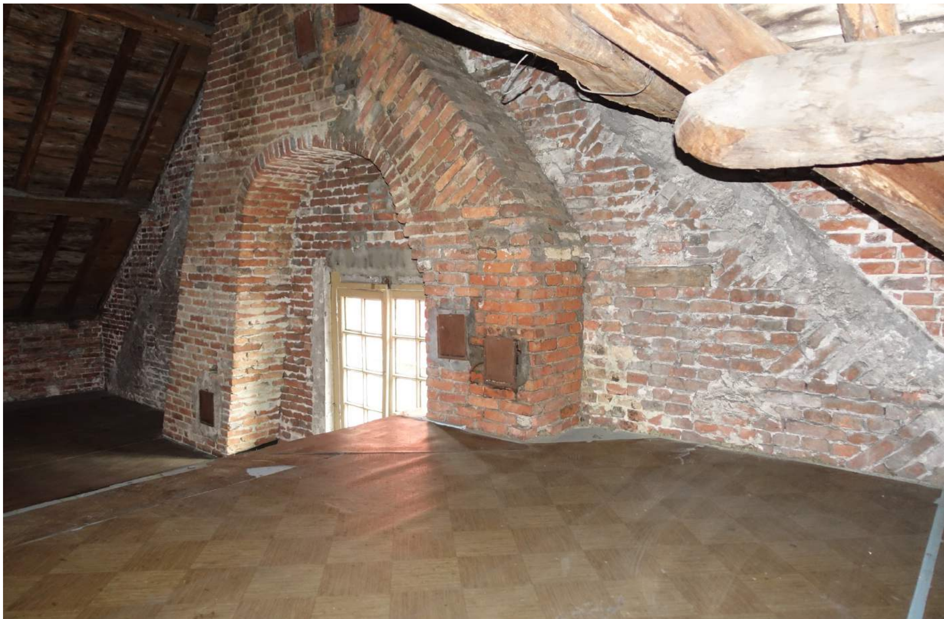
Afb. 17: In het metselwerk van de zijgevels is vanaf de zolder een mooi bouwspoor zichtbaar: daar waar de gevel in 1886-1887 werd verhoogd bleef de oude metselwerk-vlechting bewaard, waardoor het vroeger niveau en helling van het oude dak nog af te lezen is
