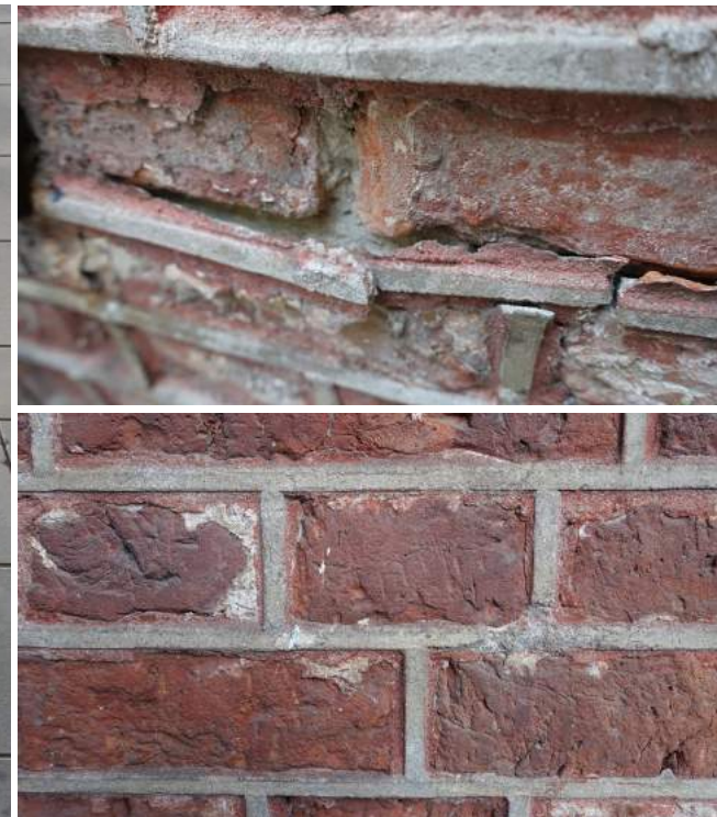
Afb. 19: Oude bakstenen met knipvoegen en roodschildering, om terug strak afgelijnde stenen te bekommen
